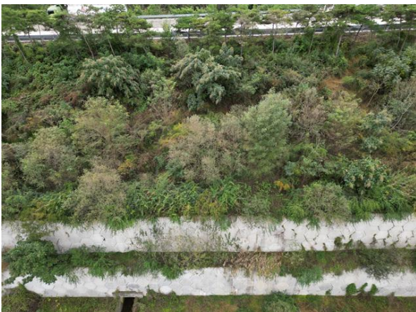
상부 성토부 상태현황
