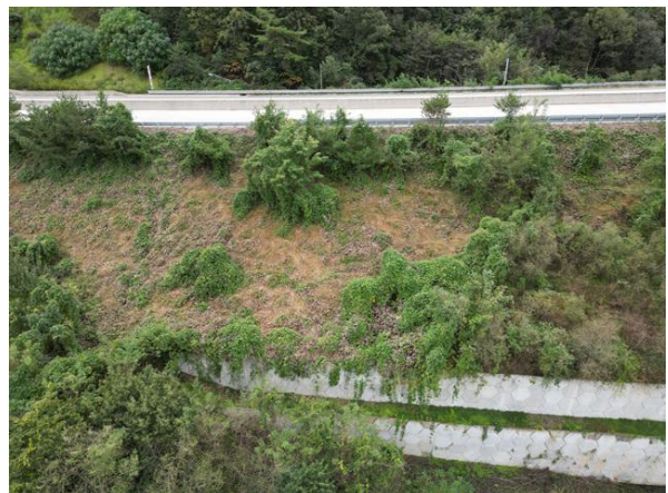
상부 성토부 상태현황
